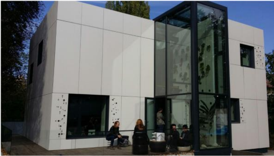
Bild 4: Auf dieses nachhaltige Gebäude können Studenten der Initiative EFdeN, Bukarest, stolz sein. Nicht nur, weil sie es mit eigenen Händen bauten, sondern weil sie für die KNX Installation mit dem Young Award geehrt wurden.
