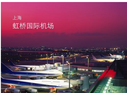
Foto 1: Der KNX Markt in China boomt seit einigen Jahren deutlich. Wichtige Projekte wie Shanghai Hongqiao International Airport oder Guansu Electric Building wurden dabei mit KNX Technik ausgestattet.
