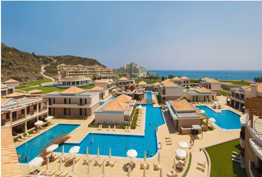
Εικ. 4: Το ξενοδοχειακό συγκρότημα La Marquise στη Ρόδο, Ελλάδα. Ο εγκαταστάτης του Συστήματος Προυσάλογλου Παντελής Κωνσταντίνος έλαβε το Διεθνές Βραβείο KNX Ευρώπη για την εκτεταμένη εγκατάσταση KNX σε αυτό το κατάλυμα.
