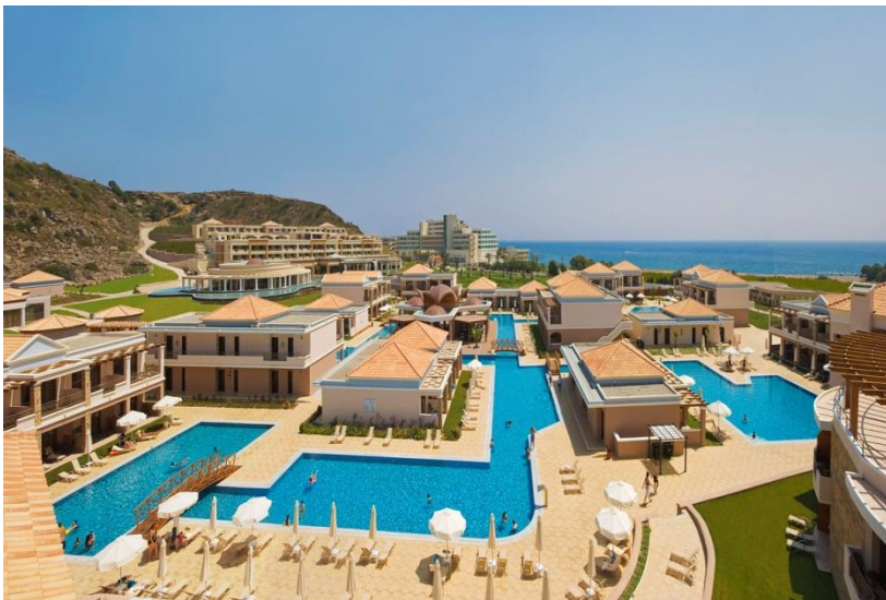
Bild 4: Hotelanlage La Marqise auf Rhodos, Griechenland. Für die umfangreiche KNX Installation erhielt der Systemintegrator Prousaloglou Pantelis-Konstatinos den KNX International Award Europa.
